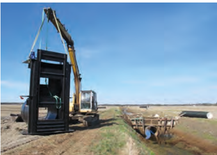
Padon asennus vuonna 2018.
